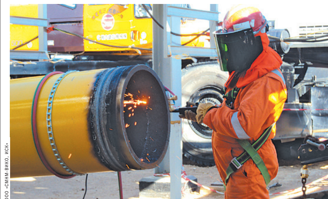
Подготовка трубы к сварочно-монтажным работам с применением орбитального трубореза.
